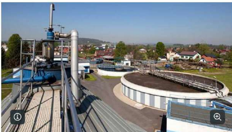
Severomoravské vodárny a kanalizace. Ilustrační foto
