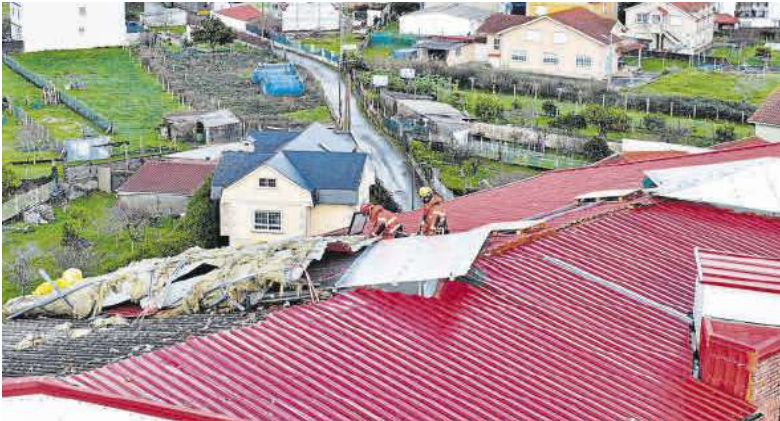
Efectivos de los Bombeiros do Morrazo, trabajando en un tejado afectado de Rodeira. | FdV
